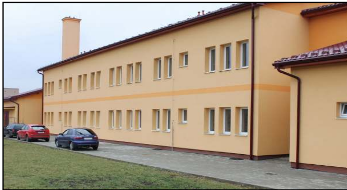
V bytovom dome sa nachádza osem dvojizbových bytov a štyri trojizbové byty. Niektoré sú už užívané. Avšak bez platného kolaudačného rozhodnutia sa byty nesmú užívať. Snímka: L. Krivda
